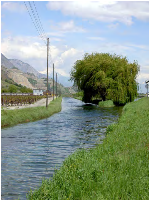
Figure 4 : Canal retouché pour offrir un contact à l'eau
