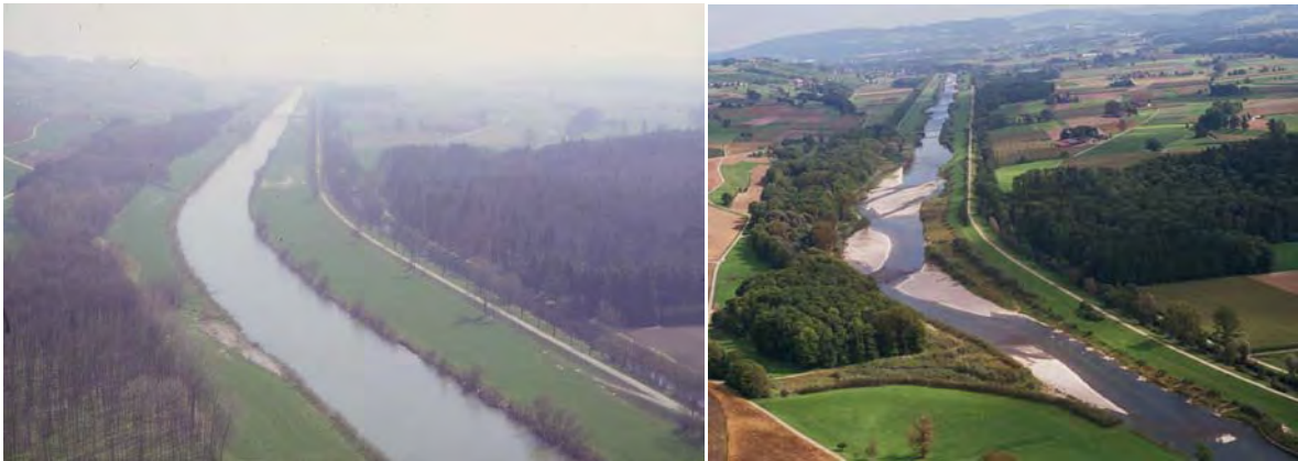
Abb. 1: Die Thur bei Altikon: Links nach der Korrektur des 19. Jahrhunderts, rechts nach der Aufweitung des Hauptgerinnes. Schon zwei Jahre nach der Revitalisierungsmaßnahme hat sich die morphologische Vielfalt deutlich verbessert.
