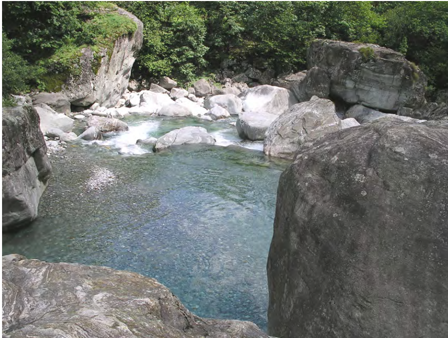
Figure 16: rivière à poissons construite de façon « naturelle »
